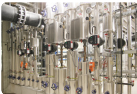
Vom Keller aus wird das Schwimmbekken gewartet
