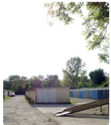
Zustand an der Garagenanlage „An der Kläranlage“
