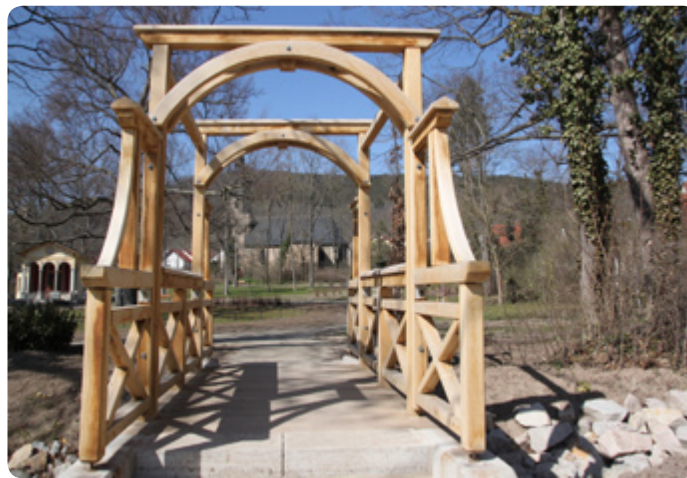
Die Holzbrücke ist ihrem historischen Vorbild nachempfunden
