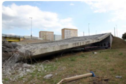
*Die alte Brücke über die Schnellstraße ist fast abgerissen. Nach der einwöchigen Vollsperrung demonitierte die Firma Streicher die Pfeiler bei laufendem Verkehr. Die Behelfsbrücke funktioniert gut und die Einschränkung der Spuren führte im Sommer kaum zu Beeinträchtigungen.*
