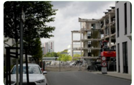
*Bis zum Herbst wird der Abriss der 1980 eröffneten Klinik für Innere Medizin (KIM) andauern. Der Langfront-Bagger ist wegen der Staubbelastung mit einer Wasserlanze ausgestattet. An der Stelle entstehen u.a. die Kliniken für Geriatrie und für Hautkrankheiten.*
