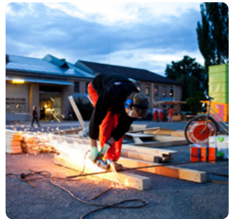
Installation auf einem Schulhof in Stuttgart, 2012 (Foto: Mor Arkadir)
