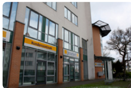
Das Jobcenter in der Tatzendpromenade ist Anlaufstelle für Arbeitssuchende und Menschen mit geringem Einkommen. (Foto: jenarbeit)
