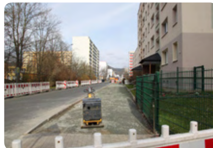
Der Fußweg wurde im März erneuert
