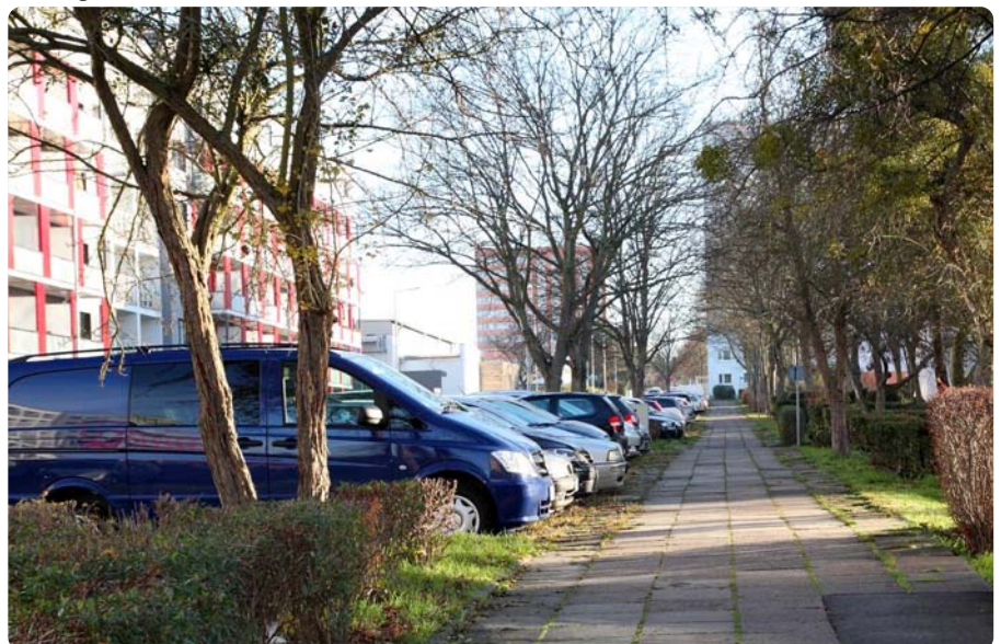
Grundlegende Sanierung geplant: der Fußweg in der Fritz-Ritter-Straße
