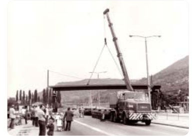
Bau der Fußgänger-Brücke in Lobeda (1978; Foto: Hans Mey)
