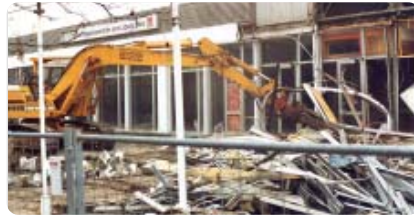
Abriss des Kulturzentrums (1998)
