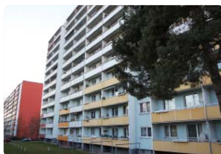
Die Fritz-Ritter-Straße 18 wird saniert
