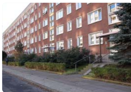
Die Fünfgeschossiger in der Binswangerstraße bekommen eine Verjüngungskur mit Vollwärmeschutz
