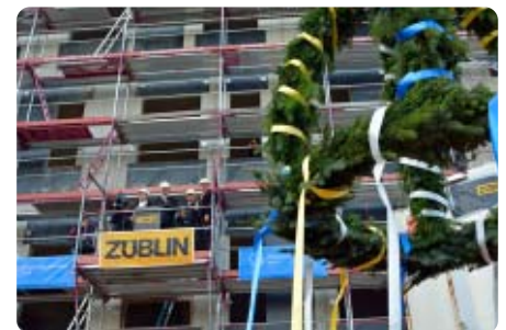
Ein Fest für die Erbauer des Klinikums: Der Richtkranz schwebt in die Höhe (Foto: UKJ, Szabo)
