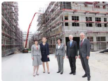
Ministerpräsidentin Christine Lieberknecht überzeugte sich vom Baufortschritt am Klinikum Lobeda
