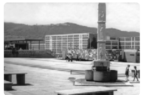
Der Marktplatz mit Brunnen, Uhr und weiteren Schmuckelementen bildete mit dem gegenüberliegenden Kulturzentrum ein eigenes Ensemble
