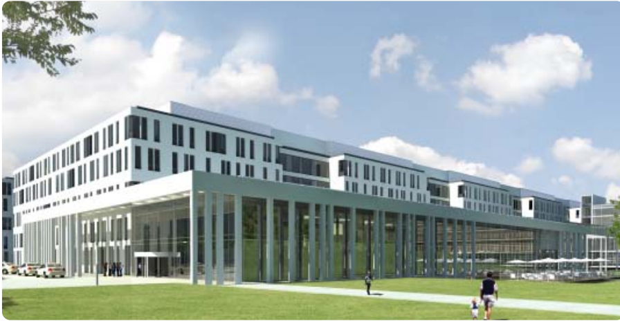
So wird das erweiterte Universitätsklinikum künftig aussehen, wenn man sich vom Park her der Anlage nähert (Architekten: Woerner und Partner Dresden)
