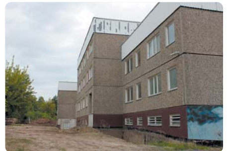
Noch lässt sich nicht erkennen, wie das Gebäude aussehen soll. Doch bald wird sich das „hässliche Entlein“ in eine komplexe barrierefreie Wohnanlage verwandeln
