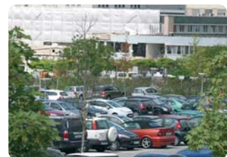
Bauarbeiten am Klinikum Seite 2
