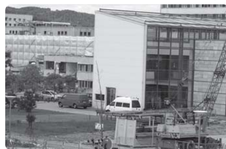
Daneben wird das Lehrgebäude des Universitätsklinikums abgerissen ▶
