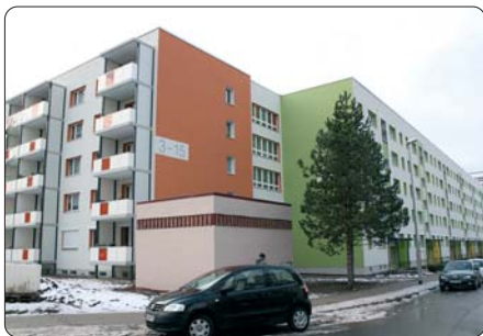
Ende 2009 konnte Jenawohnen die umfangreiche Sanierung in der Emil-Wölk-Straße abschließen. 2010 wird in den Nachbarstraßen modernisiert.
