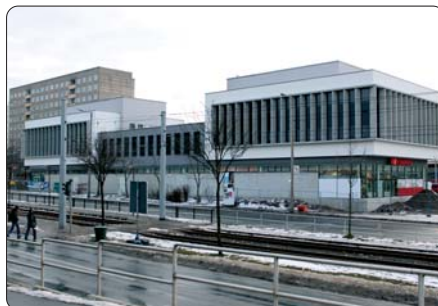
Mit den neuen Handelseinrichtungen am Salvador-Allende-Platz in Lobeda-Ost entsteht ein neues Stadtteilzentrum
