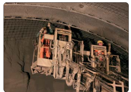
Befestigung des Gesteins: Spritzbeton wird Meter für Meter aufgebracht
