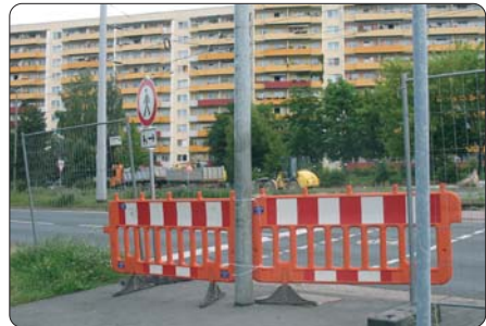
Sanierung der Erlanger Allee: bis voraussichtlich Dezember wird die Erlanger Allee ab Einmündung Stadtrodaer Straße bis zur Haupteinfahrt Klinikum grundhaft ertüchtigt. Autofahrer, Radler und Fußgänger werden um Verständnis für die notwendigen Einschränkungen, wie hier (Foto oben) am Fußgängerüberweg Bonhoefferstraße gebeten.
