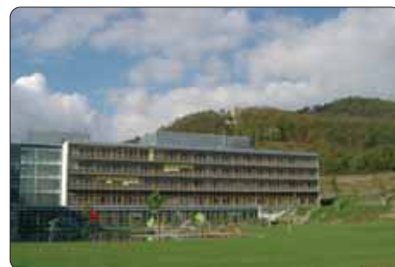
Hier wird sich der zweite Bauabschnitt anschließen
