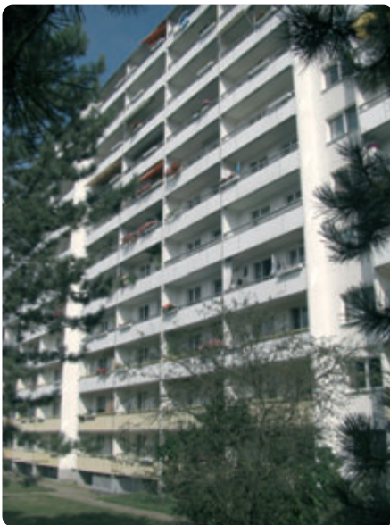
In der Kur: Die „Südlichter“ als begehrte Wohnlage direkt an der abgedeckten Autobahn
