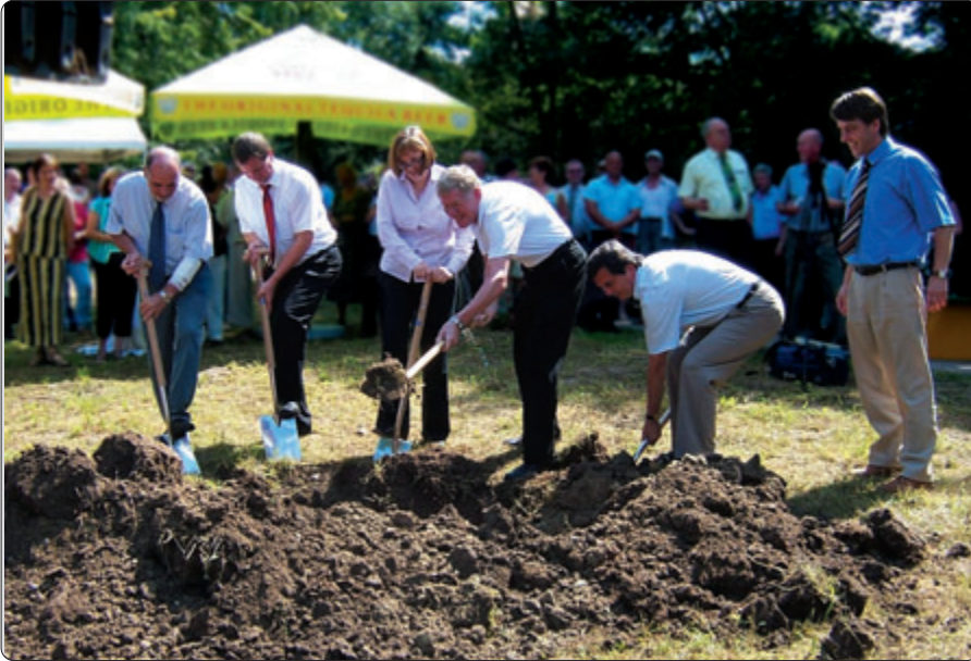
Auftakt für den Streckenneubau: bis 2009 soll der Ringschluss nach Burgau stehen.
