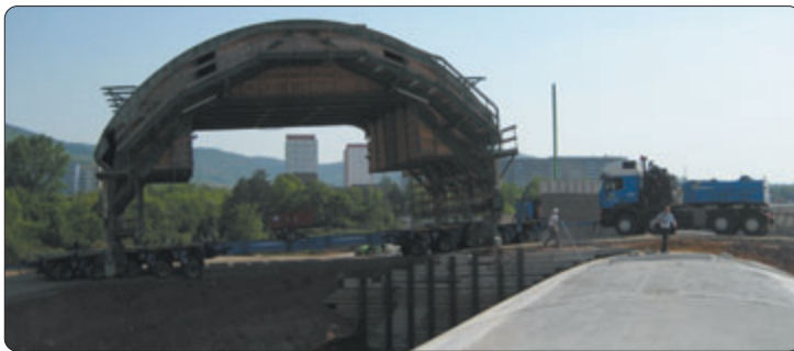
Umrücken auf der Autobahn: In einer spektakulären Aktion wurde der Schalwagen auf die andere Seite gebracht (Foto: Marc Oxfort)
