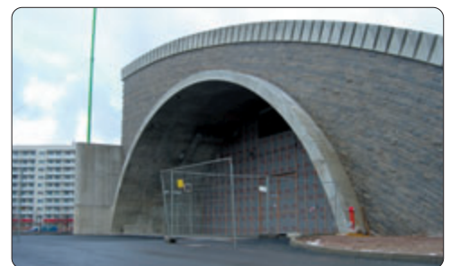
Verblendung am Westportal der Einhausung
