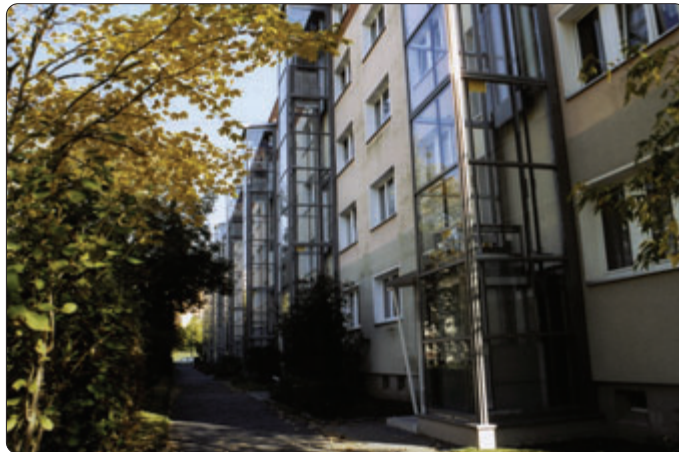
Das Gebiet der Wohnungsgenossenschaft Lobeda-West: Sämtliche Blocks haben Aufzüge bekommen
