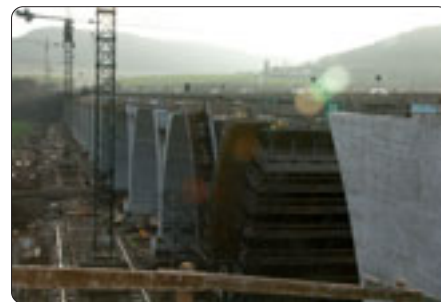
Der letzte Pfeiler der Autobahnbrücke (vorn, in der Schalung) ist gegossen
