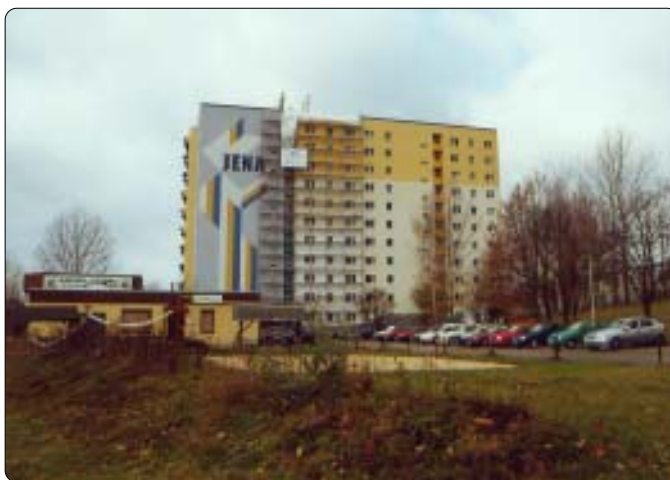
Der 30 Meter hohe Vorbote von Jena wurde jetzt nach den Originalvorlagen saniert.
