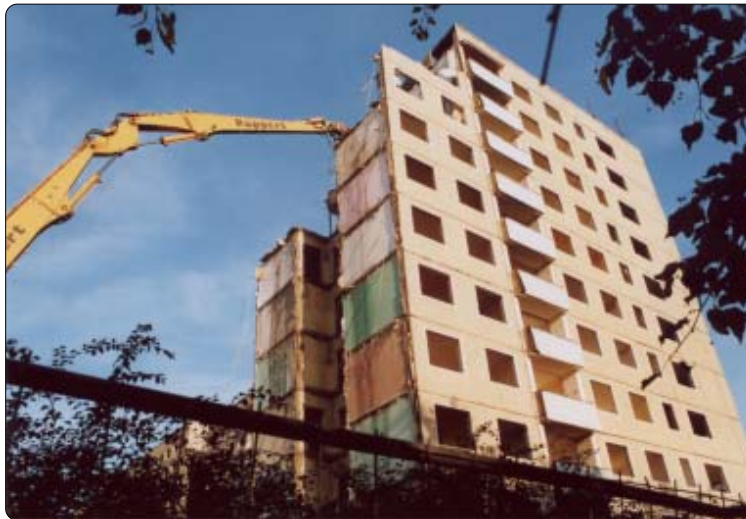
Ein 110 Tonnen schwerer Abrissbagger leistet in der Ebereschenstraße ganze Arbeit
