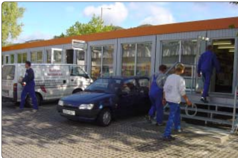
Schöner, heller und dazu großzügig: Die drei Geschäfte sind zufrieden über ihren neuen Pavillon
