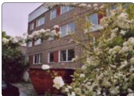
Das Innere der ehemaligen Kindereinrichtung wurde vollständig entkernt
