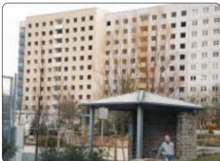
„Rückbau“ im wörtlichen Sinne: Die Häuser Sanddornstraße 6 und 8
