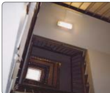
Die Erneuerung der Sicherheitseinrichtungen erhöht die Sanierungskosten auf das Fünffache
