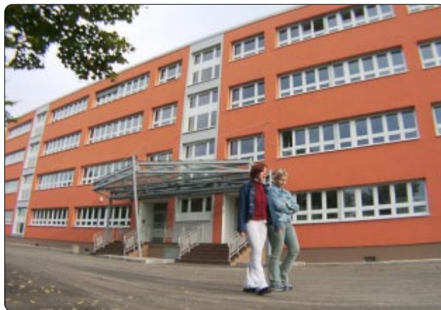
Die Sanierung der ehemaligen 11. Grundschule (Foto) wurde in diesem Sommer abgeschlossen. Bis zum Jahresende soll das Nachbar-Schulgebäude (vormalige Döbereiner-Schule) bezogen werden.
