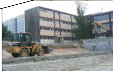
Mitte August: Die Sitzarena entsteht
