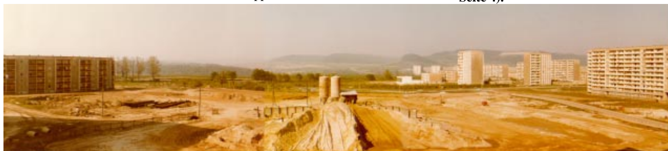
Dieses von einer Anwohnerin zur Verfügung gestellte Panorama ist auf Mai 1981 datiert. Es zeigt den Allendeplatz noch als Baustelle. Bald werden die Häuser der Ebereschenstraße (rechts im Bild) einer Neubebauung weichen.
