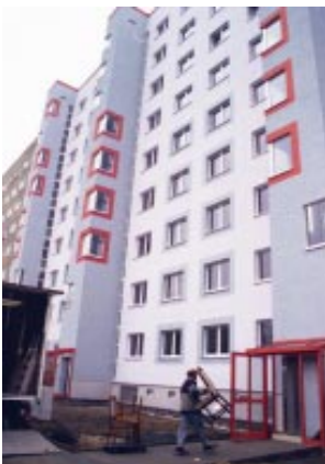
Nach den Handwerkern kommen die Möbelwagen
