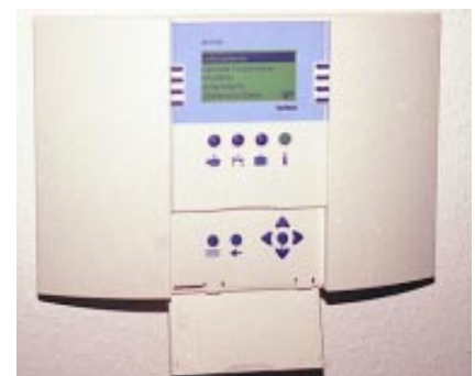
Die Wohnungszentrale regelt alle Heizkörper und zeigt den Verbrauch an
