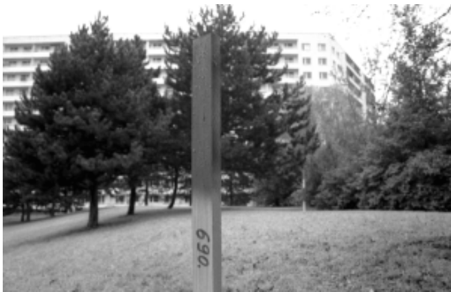
Markierungspfähle wie dieser auf den Grünflächen nördlich der Autobahn stecken den Verlauf eines für die Baustelle notwendigen Kabels ab. Gebaut wird zuerst auf der Südseite.
