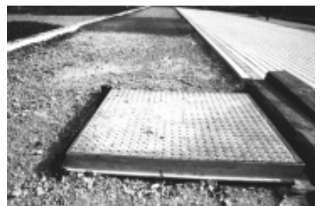
Der neue Weg verläuft über einen Sammelkanal der Stadtwerke.
