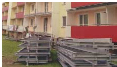
Spezialrahmen machen Ausbau möglich
