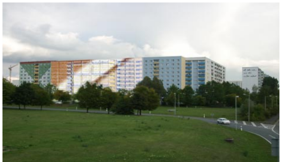
Zwischen „Eieruhr“ und „Ich sehe was...“ wird ab nächstem Jahr eine Glasfassade neue Akzente setzen. Die Montage versucht davon einen Eindruck zu vermitteln.
